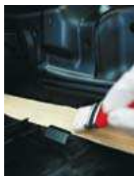
Sigillatura pennellabile della giunzione
