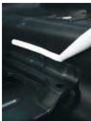
Sigillatura di giunzioni
