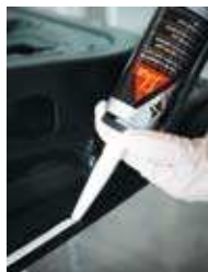
Sigillatura di giunti
